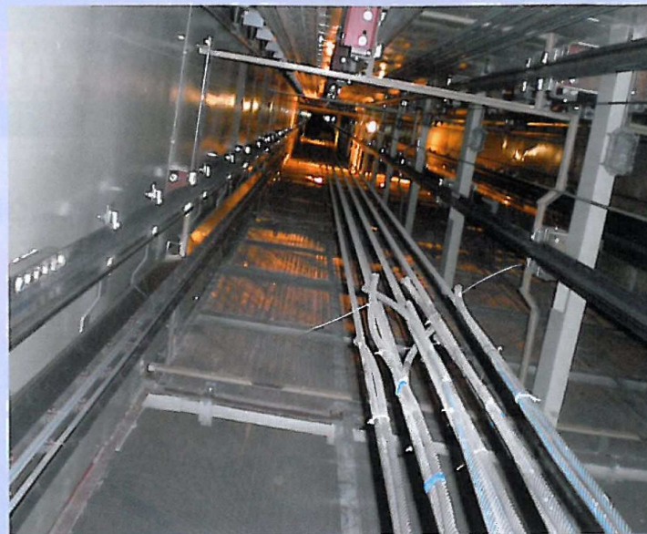
Herausforderung 350 Meter: Die Experten von WirelessConsulting installierten eine roamingfreie WLAN-Steuerung in drei Aufzugschächten.
